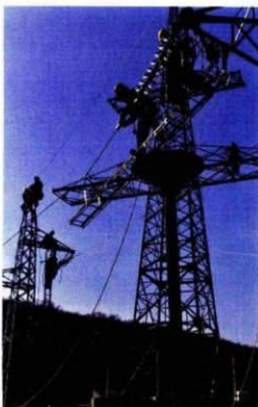
Na poligonu HEP NOC-a, monteri Dalekovoda vježbaju zamjenu izolatora i raspuštanje vodiča te...
